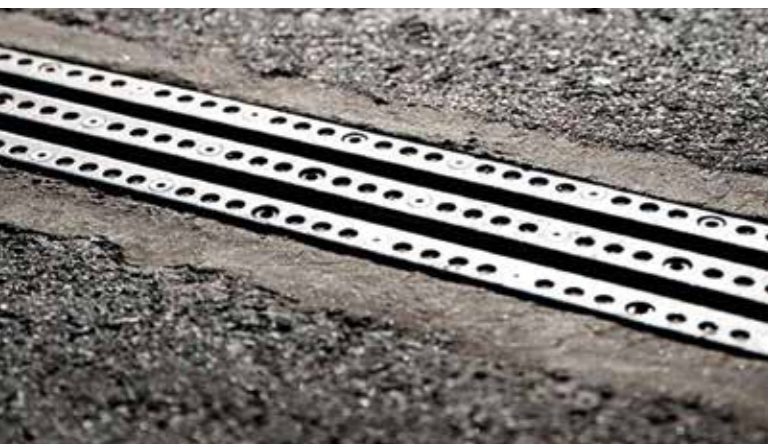
Route à induction en Suède
